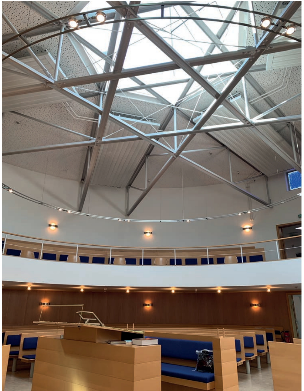
Blick in die Dachkonstruktion der Synagoge, die einem Davidstern nachempfunden ist
